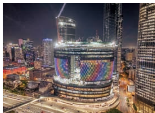
布里斯本Queen's Wharf Brisbane之建築地盤
