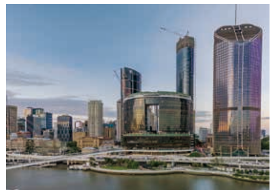
布里斯本Queen's Wharf Brisbane建築地盤
