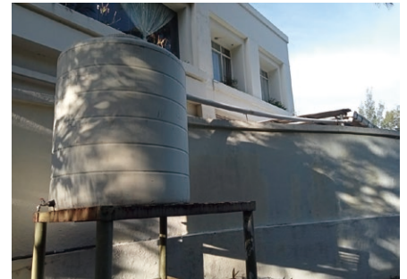
Dorsett Shepherds Bush的 雨水收集系統
